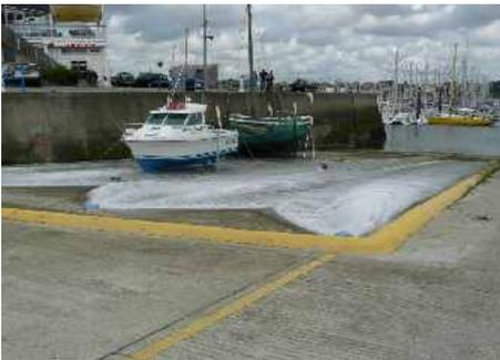
Pour la première fois depuis sa mise en service, cette cuve, pleine au 2/3 de sédiments pollués, résultat des 500 passages, a été vidée et les sédiments transférés pour un coût total de 1500 €. C'est le seul coût de fonctionnement induit par l'installation, qu'il faudra vraisemblablement compléter du prix de quelques interventions de dépannage et de maintenance une fois achevée la période de garantie.
